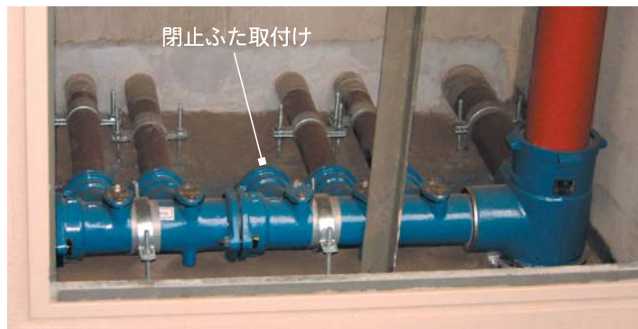
▲排水ヘッダ 設置例 (PS内設置、閉止ふた使用例) (オプション)
