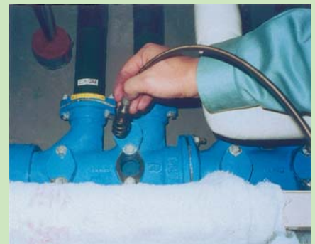
▲ねらいの横枝管の掃除口から洗浄ノズルを挿入し、横枝管内を清掃
