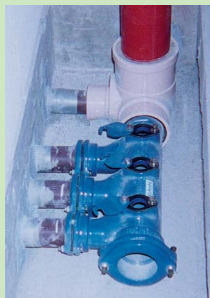
▲排水ヘッダ 設置例 (トレンチ内設置)
