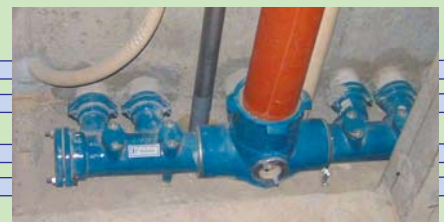
▲ねらいの横枝管の掃除口から洗浄ノズルを挿入し、横枝管内を清掃
